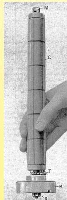
1928: "Electro-cumul", Elektro-Warmwasserbereiter, seit 1925 hergestellt von Etelec, Etablissement électromécaniques de Strasbourg. Der Warmwasserbereiter ist ein Einrohrgerät mit einem Keramikzylinder, auf dem Heizdrähte aufgewickelt sind. Das Wasser wird auf 95°C erhitzt. (Ultimheat Museum)
